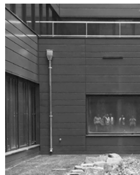
Abb. 50: Außenliegendes Fallrohr mit Wasserfangkasten und danebenliegendem Speicher als Notentwässerung
