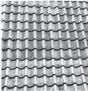
Abb. 25: Dachdeckungen aus verformten Schuppen
