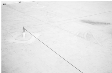
Abb. 56: Seilsicherungssystem
