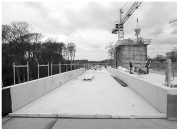
Abb. 33: Flachdach aus Stahlbeton
