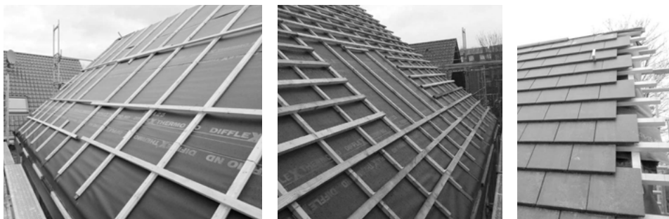
Abb. 23: Dachaufbau im Baufortschritt: Unterspannbahn, Konterlattung, Lattung und Eindeckung
