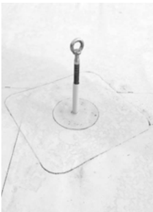
Abb. 55: Montage- und Endeinbauzustand eines Einzelanschlagpunktes in einem Foliendach
