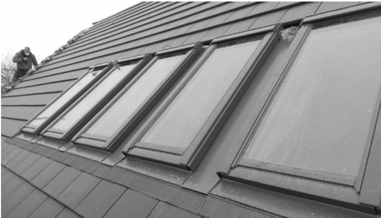
Abb. 13: Dachfenster im fertigen Einbauzustand
