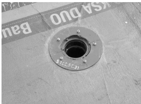
Abb. 49: Einbau eines Dacheinlaufs in der Abdichtungsebene
