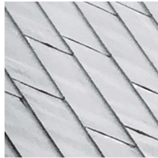
Abb. 26: Dachdeckungen aus Blech
