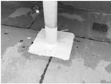
Abb. 35: Andichtung einer Stahlkonstruktion mit Flüssigkunststoff innerhalb der Dachfläche
