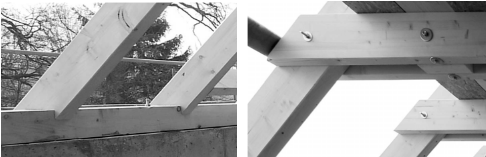
Abb. 15: Anbindung von Sparren an die Fußpfette mit einem Fersenversatz
