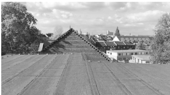
Abb. 41: Dach mit oberster Abdichtung aus Bitumenbahnen
