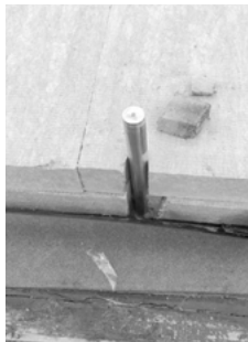
Abb. 55: Montage- und Endeinbauzustand eines Einzelanschlagpunktes in einem Foliendach
