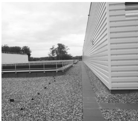
Abb. 43: Flachdach mit Kiesschicht
