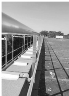
Abb. 53: Montage- und Endzustand einer Geländerbefestigung mit Z-Winkeln unterhalb der Attikaabdeckung
