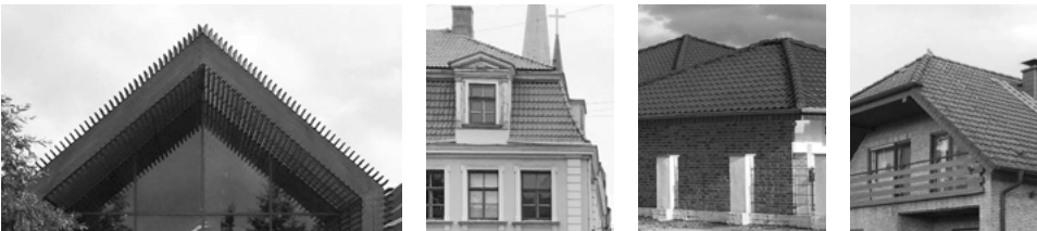
Abb. 5: Satteldach – Mansarddach – Zeltdach – Krüppelwalmdach
