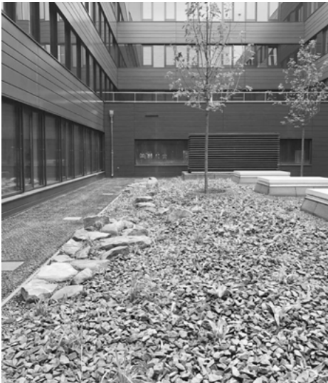
Abb. 44: Dachfläche bekiest und intensiv begrünt, ca. 1 Monat nach Bepflanzung
