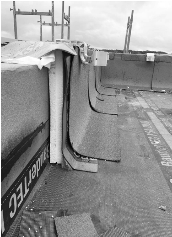
Abb. 37: Schichtenaufbau gedämmte Attika
