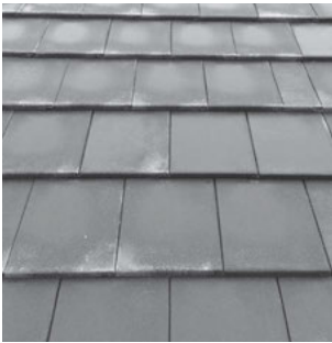
Abb. 24: Dachdeckungen aus ebenen Schuppen
