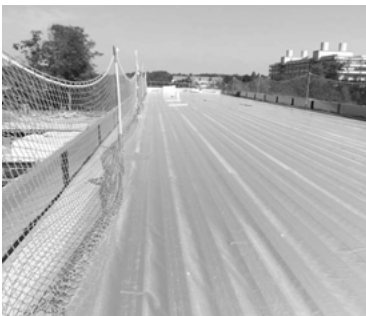
Abb. 39: Trennlage auf Trapezblech
