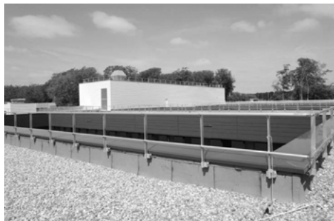
Abb. 53: Montage- und Endzustand einer Geländerbefestigung mit Z-Winkeln unterhalb der Attikaabdeckung
