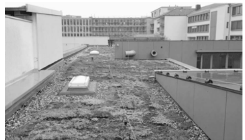
Abb. 45: Extensive Dachbegrünung, ca. 5 Jahre nach Fertigstellung
