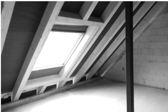
Abb. 7: Wechsel zum Einbau eines Dachfensters
