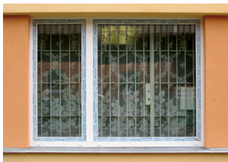
217 Fassade ›ohne Gitter‹
