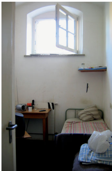
148 Haftraumfenster: Parapethöhe um 1890
