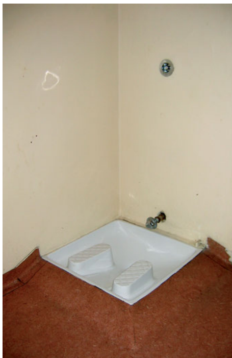
117 Sanitäreinrichtung der Hausarrestzelle
