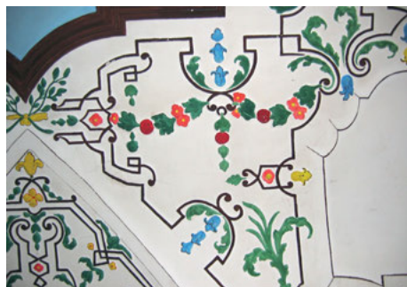
205 Gut gemeint: trotzdem - Vandalismus
