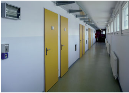
143 Haftraumtür mit Hotelsperre
