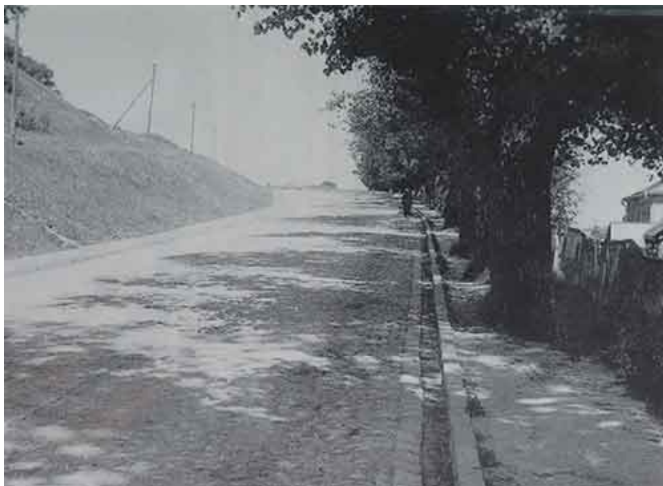
La calle que conduce al Fuerte IX, agosto de 1944.
