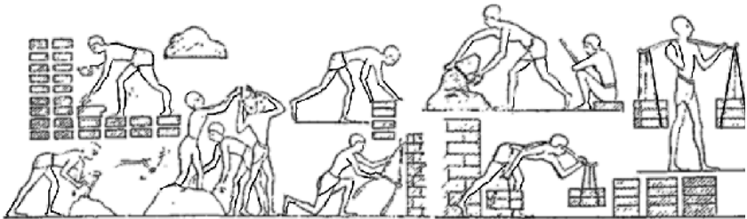
Fig. 1.-- Fabrication de la brique
