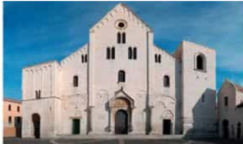
Façade de la basilique Saint-Nicolas de Bari, XII e siècle.
