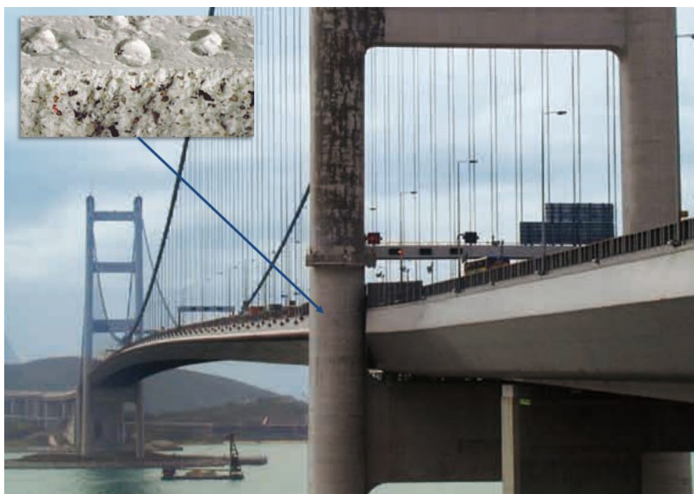
FIGURE 9.9 – Protection d'un ouvrage en béton à l'aide d'une impression hydrophobe
