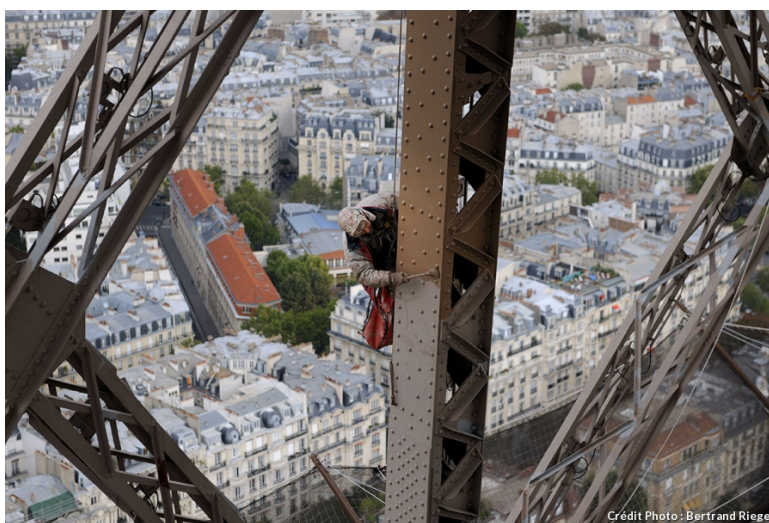
FIGURE 9.15 – La Tour Eiffel doit sa longévité en grande partie à la peinture qui la recouvre. Elle a été repeinte dix-neuf fois depuis sa construction, soit une fois en moyenne tous les sept ans. « On ne saurait trop se pénétrer du principe que la peinture est l'élément essentiel de la conservation d'un ouvrage métallique et que les soins qui y sont apportés sont la seule garantie de sa durée » (Gustave Eiffel, 1900).
