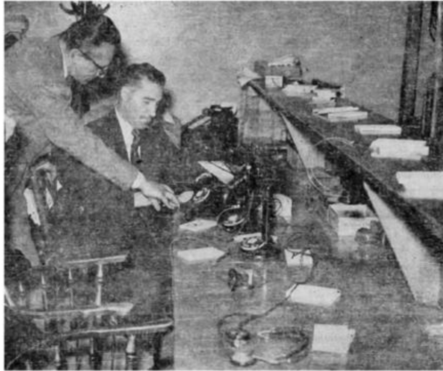
Installation téléphonique d'une maison de pari du centre-ville de Montréal
