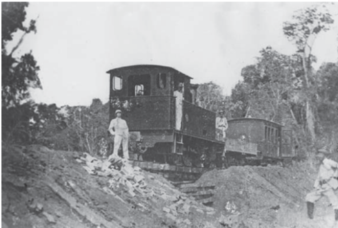
FIGURA 16 - A simplificação das obras durante a construção da CEFNOB. Execução de um bueiro. Foto sem data (Centro de Memória Regional, RFFSA/UNESP. Bauru, SP).
