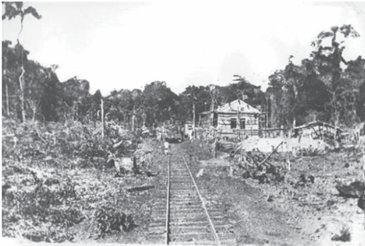
FIGURA 14 - Construção de uma estação da CEFNOB, em plena mata. Foto sem data (Centro de Memória Regional, RFFSA/UNESP. Bauru, SP).
