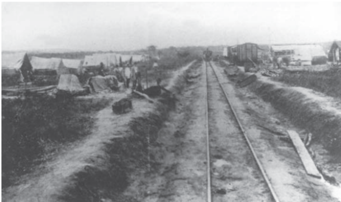
FIGURA 17 - Dormentes implantados diretamente sobre o solo. Foto do acampamento de trabalhadores localizado no quilômetro 298. Foto sem data (Centro de Memória Regional, RFFSA/UNESP, Bauru, SP).
