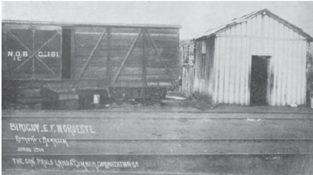
FIGURA 28 - "Estação" e armazém de Birigüi. Foto de 1914 (Ramos & Matins, 1961, p.93).
