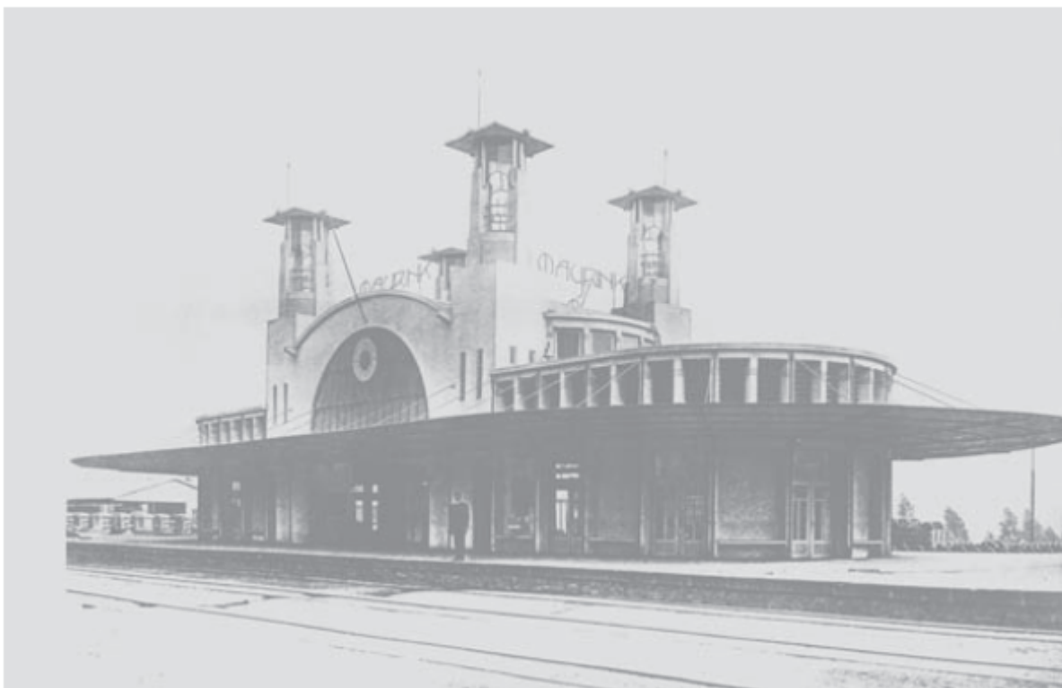
FIGURA 20 - A sofisticação arquitetônica e estrutural da pequena estação de Mairinque, projetada em 1906 por Victor Dubugras (Reis Filho, 1997).
