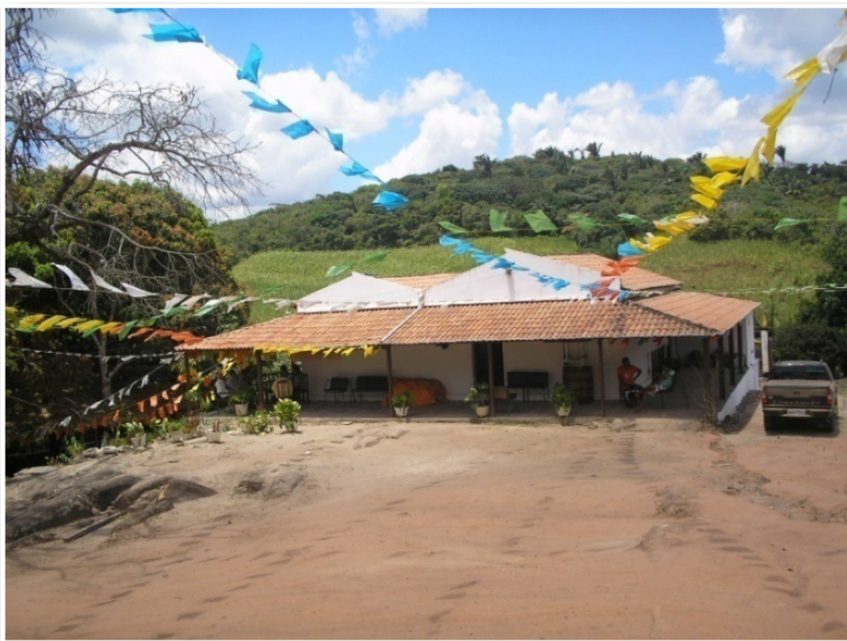
Figura 40 Vista frontal da casa grande.
