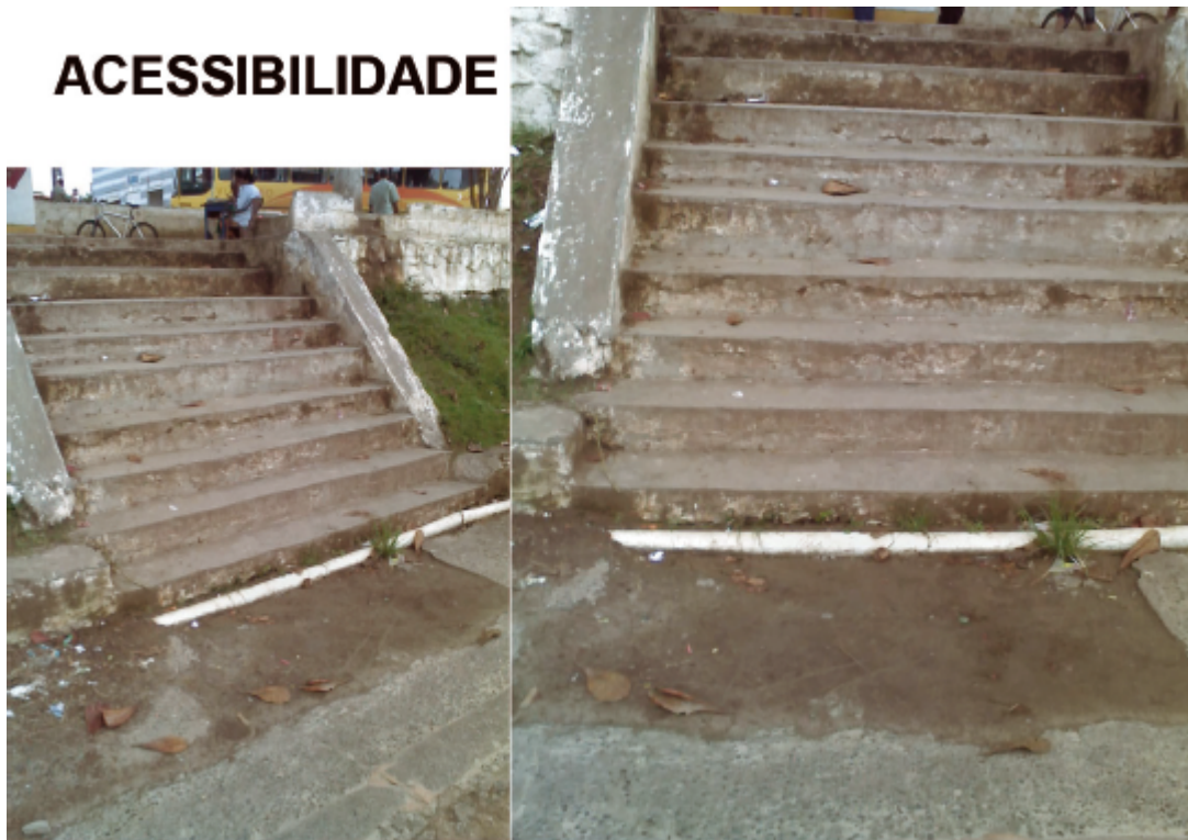
FIGURA 7 – Escadas de acesso da BR 415 ao bairro Salobrinho
