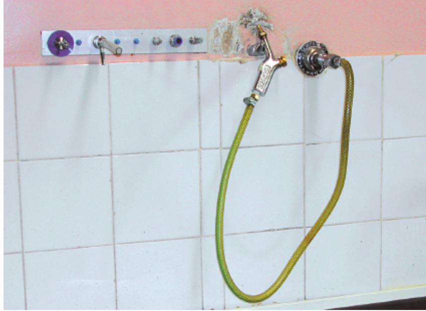
Figura 3.3 Pistola de ar comprimido do Hospital Universitário Clementino Fraga Filho para auxiliar a secagem de material.
